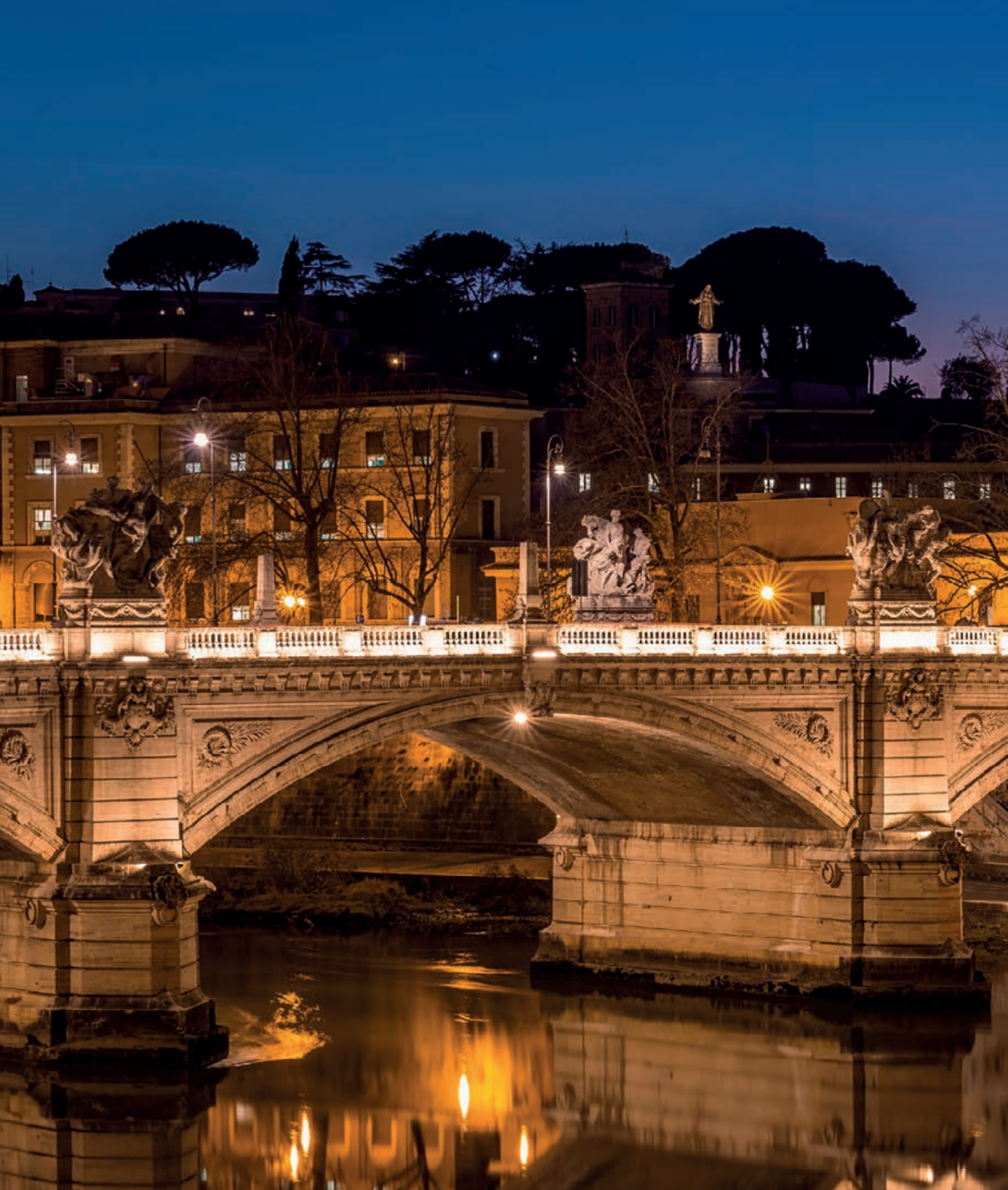
Vittorio Emanuele II bridge
